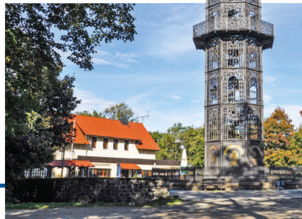
Der filigran anmutende König-Friedrich-August-Turm besteht aus über 1.000 Einzelteilen, die zusammengesteckt und mit Blei verschlagen wurden.
